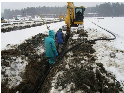
吸水渠布設状況
